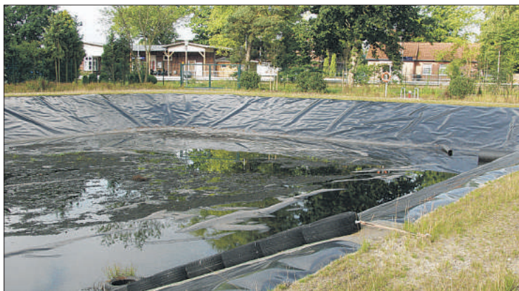
Das Regenwasserrückhaltebecken am Heidkampsweg entstand als bislang letztes in Schneverdingen. Es musste mit einer Folie ausgekleidet werden, da es sich neben dem Brunnen des Wasserwerks befindet.
