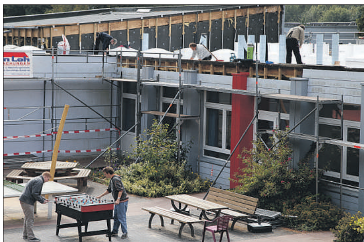
Die Lebenshilfe saniert das Dach der Tagesbildungsstätte.
