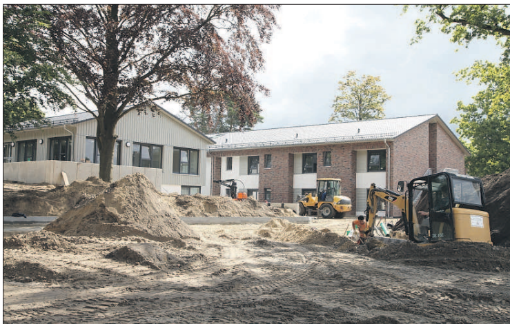
Derzeit werden die Außenanlagen rund um das neue Wohnheim der Lebenshilfe gestaltet, und es finden Pflasterarbeiten auf dem Gelände an der Winsener Straße statt. Parallel läuft der Innenausbau Foto: wu
