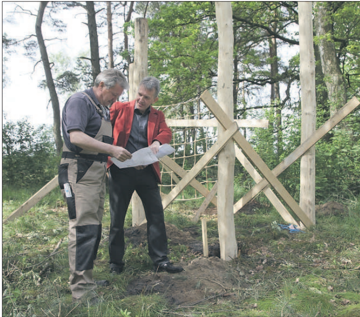
Bauleiter Jens Schröder (links) und Lebenshilfe-Chef Gerhard Suder überzeugen sich auf dem Bauplan vom künftigen Aussehen der Burg, die die Lebenshilfe im Wald errichtet. Foto: wu
