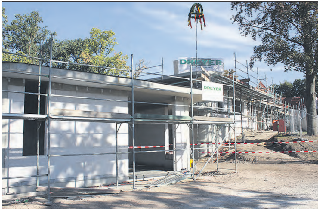
Richtfest für die neue Kindertagesstätte der Lebenshilfe Soltau, die in den erste Monaten des kommenden Jahres fertiggestellt sein soll. Fotos: mwi
