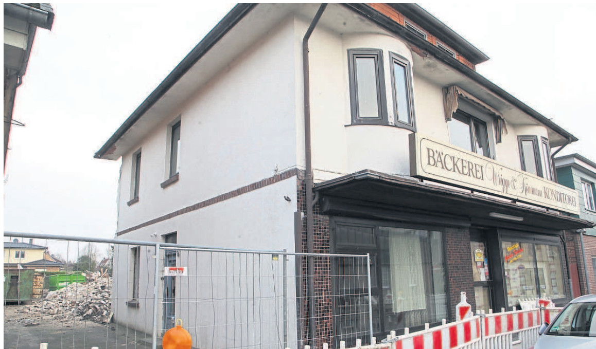
Im Laufe der Jahre änderte sich die Fassade der Bäckerei Wrigge und Könemann. Jetzt wird das Haus komplett abgerissen, ein Neubau entsteht.
