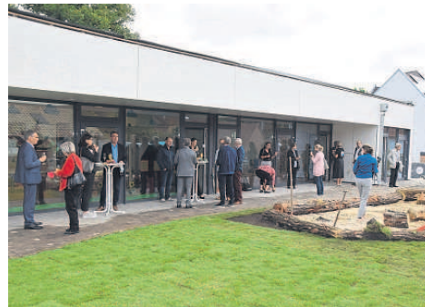
Auch der Außenbereich der neuen Kita ist fast fertig, damit die Kinder am Dienstag die Einrichtung beziehen können. Foto: emh
