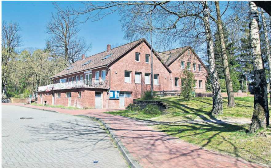
Unten trainieren hauptsächlich die Senioren, oben spielt der Nachwuchs: Der MTV richtet in seinem Sportlerheim eine Kindertagesstätte ein. Im Obergeschoss wird Platz für 50 Kinder geschaffen. Foto: at
