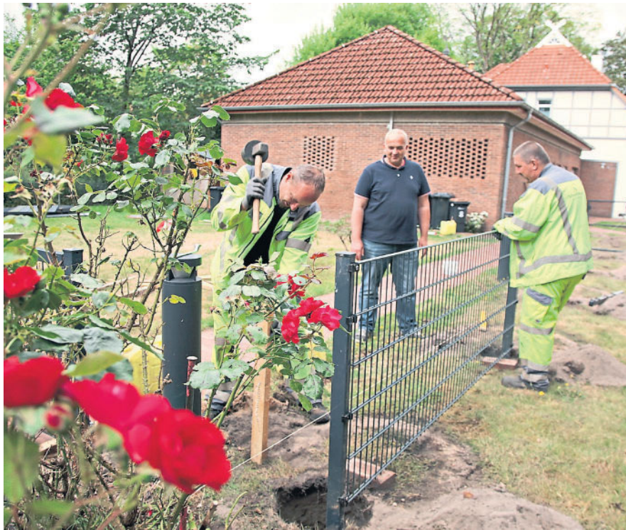
Karl-Heinz Norrmann (rechts) und Stephan Heuer vom städtischen Bauhof setzen den Zaun, damit die Kinder zukünftig geschützt draußen spielen können. Bauamtsmitarbeiter Andre Krampe (Mitte) betreut die Baumaßnahme an der katholischen Kirche. Foto: jul
