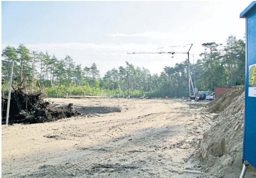
An der Winsener Straße entsteht gegenüber der BBS II aktuell eine neue Kindertagesstätte in Soltau. Bauherrin ist die Lebenshilfe. Das Gebäude wird eingeschossig und bietet Platz für sechs Gruppen für Kinder im Krippen- und Kindergartenalter. Foto: at
