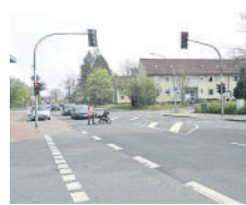
Eine Ampelanlage speziell für Fußgänger (hier in Munster in Höhe des Bürgerhauses).
